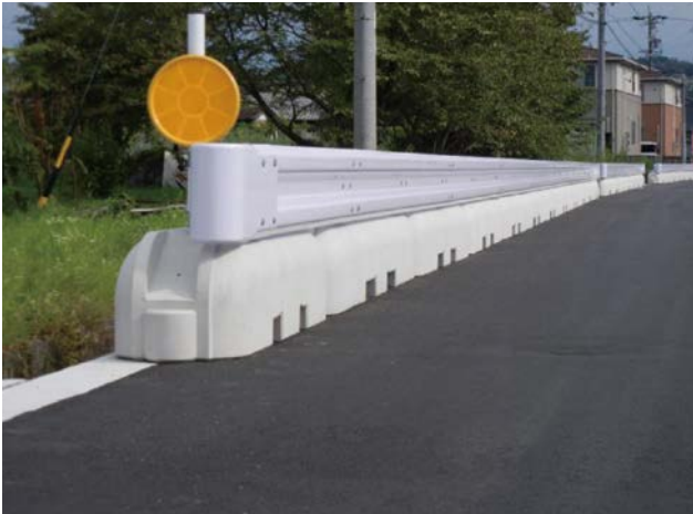
置き設置にて施工
