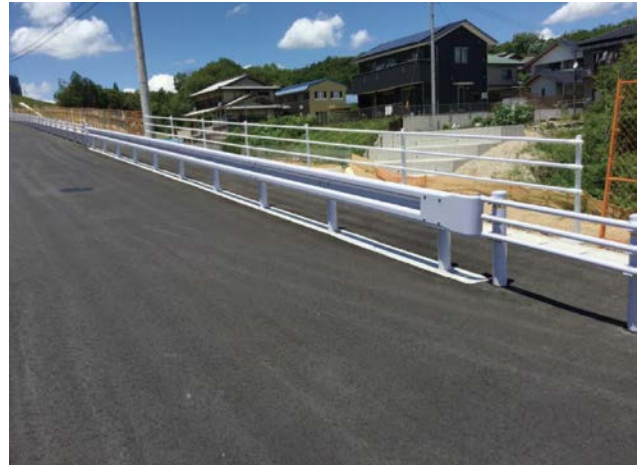
埋設設置にて施工
