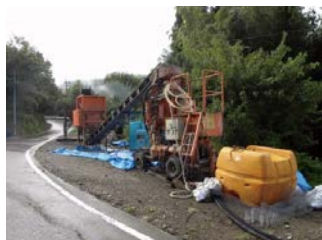
吹付け機械一式
