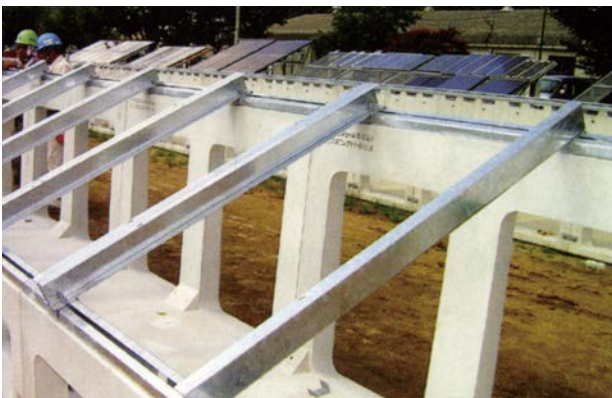
⑤モジュール受材取付け
