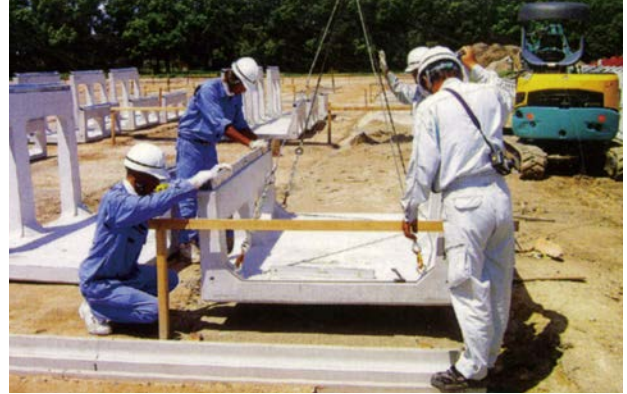
②製品敷設
