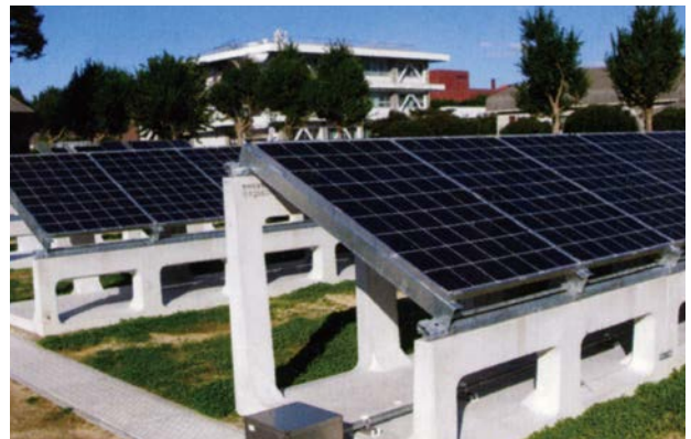
⑥モジュール取付け
