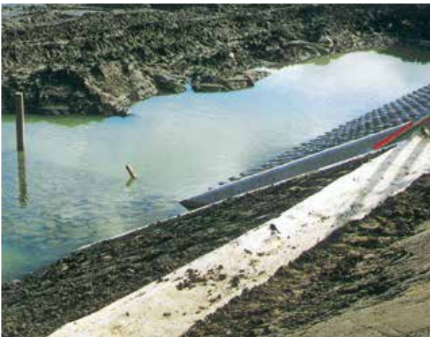
覆土は製品天端より 5 cm程度が好ましい
