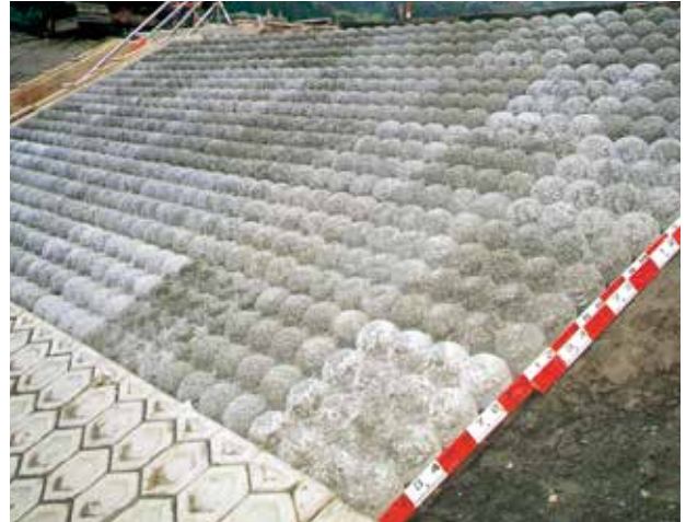
製品敷設完了
