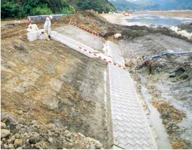
法面成型完了
