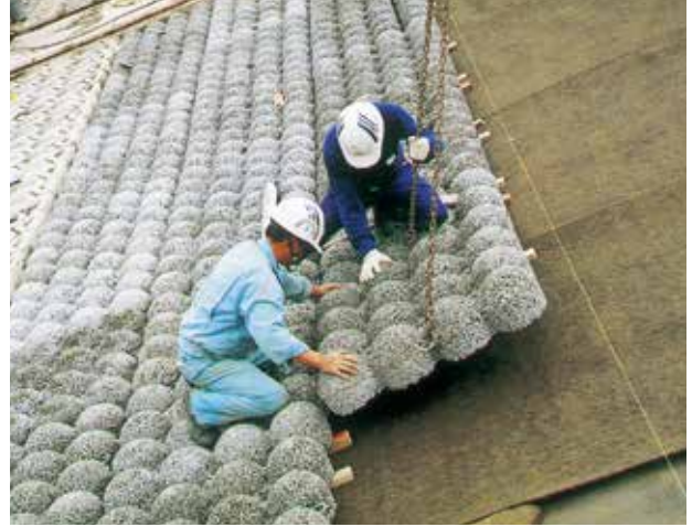
製品敷設状況 (連結金具を利用)
