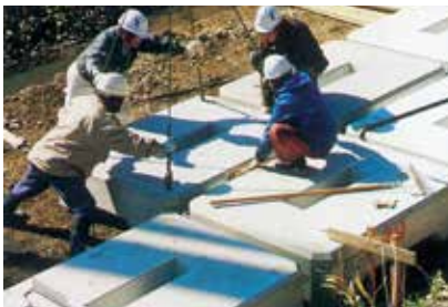
①ブロック据付
