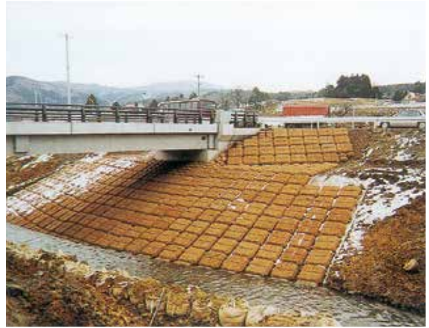
④ブロック設置完了
