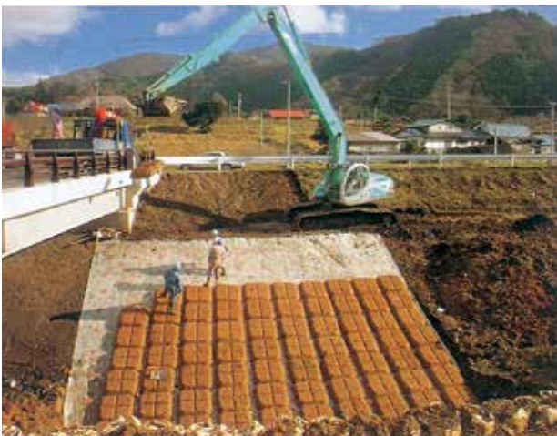
③施工中（ブロック設置）
