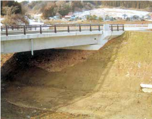
②施工開始（法面整地）
