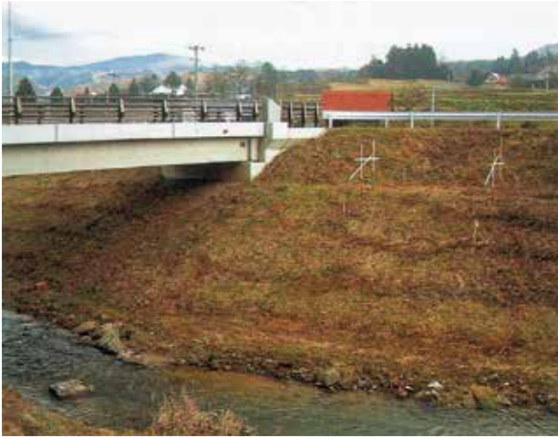
①施工前（造り方設置）
