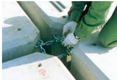
②チェーンとシャックルによるブロック間の連結
