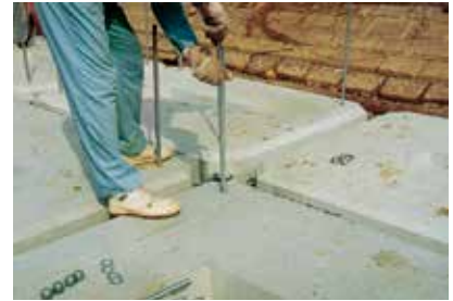
③組立ボルト建込み
