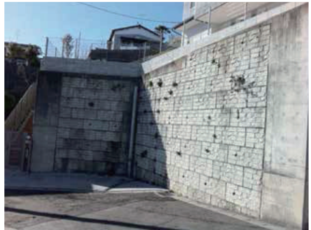
2011年4月20日撮影 宮城県仙台市太白区(物件箇所震度5強) レンガ模様 H=4~6m ブロック段数6~11段
