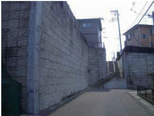
2011年3月30日撮影 宮城県塩釜市(物件箇所震度6強) 小レンガ模様 H=5~9m ブロック段数8~15段
