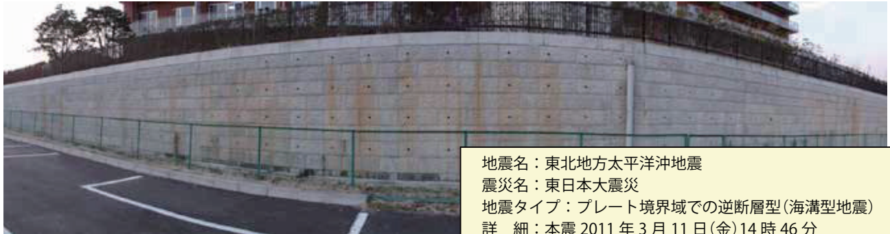
2011年3月29日撮影 宮城県仙台市泉区(物件箇所震度6弱) 大谷石模様 H=3~8m ブロック段数11~13段
