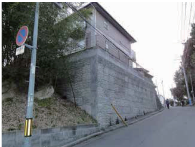
2011年3月29日撮影 宮城県仙台市青葉区(物件箇所震度6弱) 小レンガ模様 H=4~5m ブロック段数6~8段
