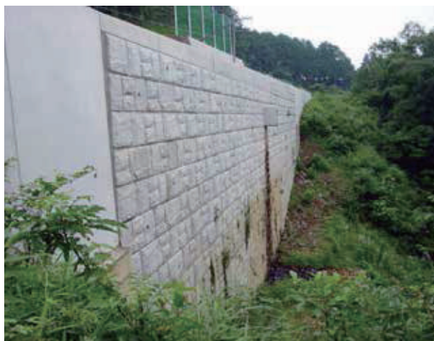
東郷町建設課 町道山之口福瀬大橋線
