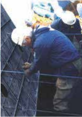
5] KCパネルの固定
