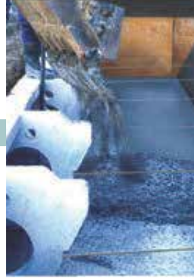
7] 胴込・裏込コンクリートの打設
