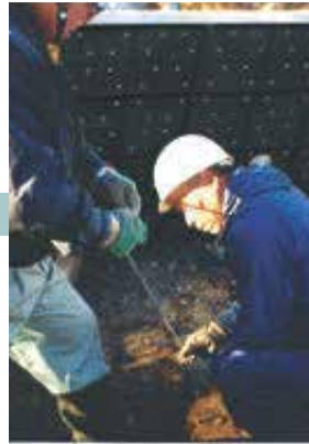
3 KCパネル固定ナットの取付け
