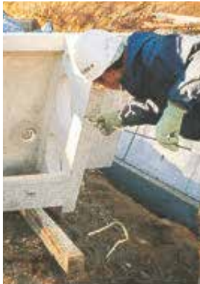
1 セパレーターの取付け
