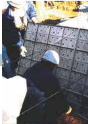
2 KCパネルの取付け
