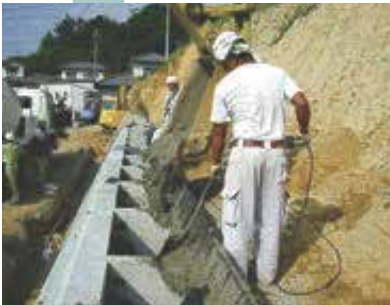
4 胴込コンクリートの打設
