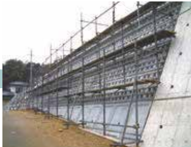
5 据付け完了及び足場設置
