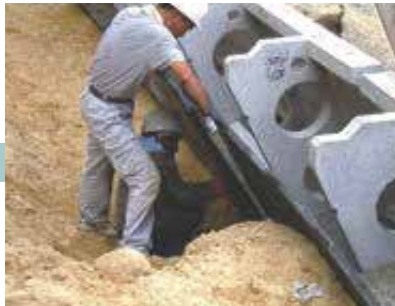
2 KCパネルの固定
