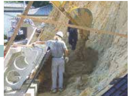
3 裏込材料の投入
