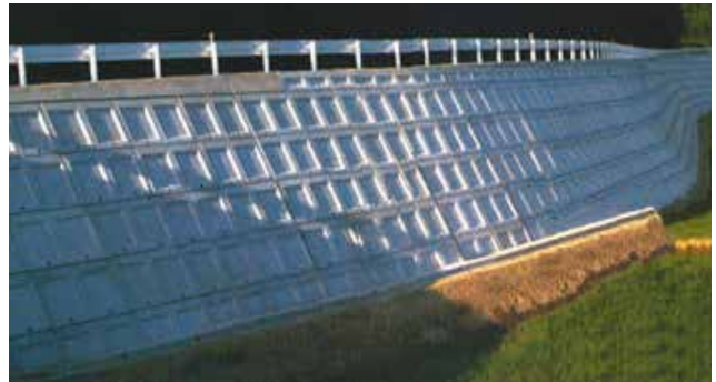
天端に構造物を付けた使用例 [ガードレールを設置した場合]
