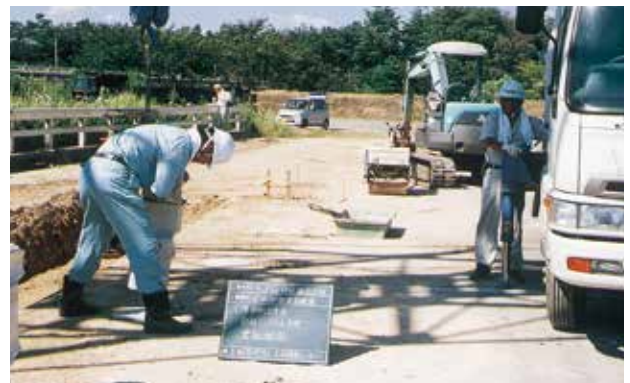
⑧支柱建て込み
