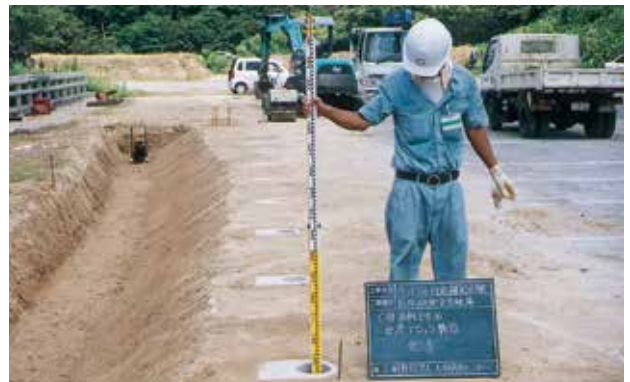
⑥鋼管及び台座ブロック施工完了
