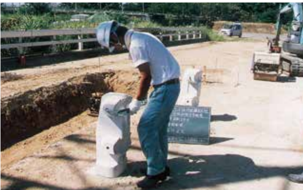
⑪ 連結プレート取付
