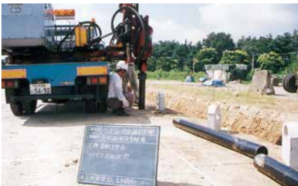
③鋼管打込み
