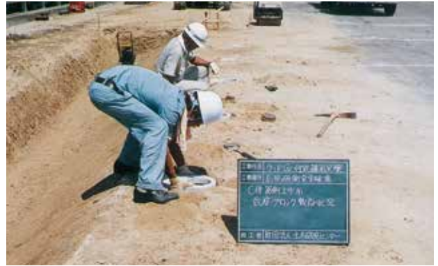
⑤台座ブロック据付
