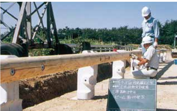
⑫ Rナットによるビーム固定 (上下ビーム共に施工)
