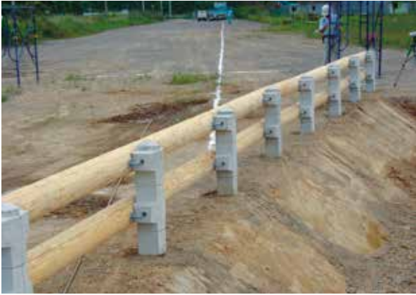
ウッドGr-P型設置状況(背面)
