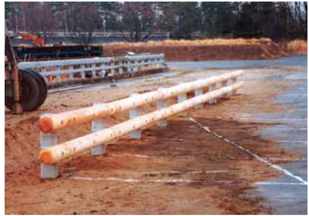
ウッドGr-P型設置状況(正面)
