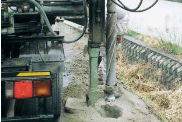
①削孔、深さ検査(φ150-1700mm程度)
