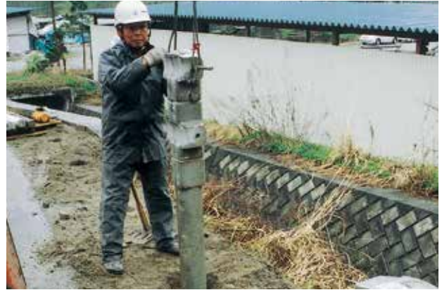
②鉄筋コンクリート支柱挿入
