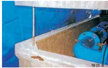
▲上・下接着 接着剤および水膨潤ゴムで止水。
