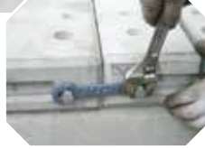
ジョイントプレートに専用ボルトと樹脂ワッシャーをセット
