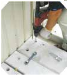
コンクリートアンカー ブロック上から下穴を開け（口径12mm 深さ55mm以上）
