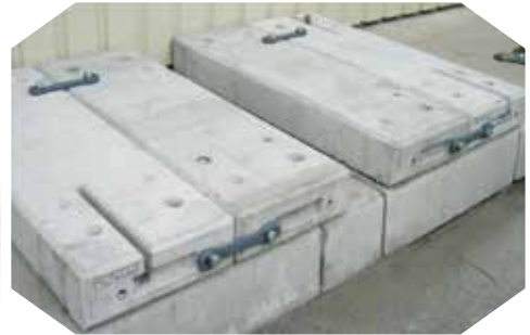
ジョイントプレートに専用ボルトと樹脂ワッシャーをセット
