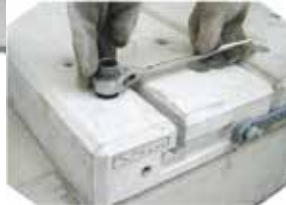
コンクリートアンカー ブロック上から下穴を開け（口径12mm 深さ55mm以上）
