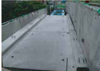
既設桁等の補修を実施後、ダクトアルスラブ 6 枚敷設(参考重量：2731kg/ 枚)
