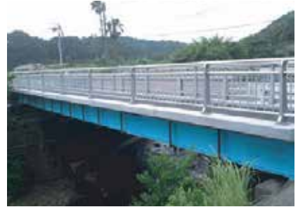
幅2600mm×厚さ320mm×長さ3120mm (歩道幅 2000mm、最少厚 60mm)
