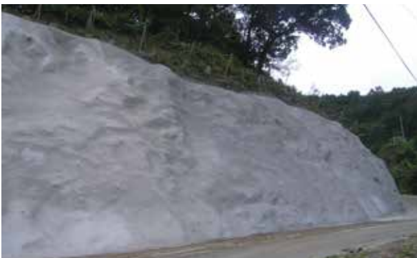
【モルタル吹付工】
