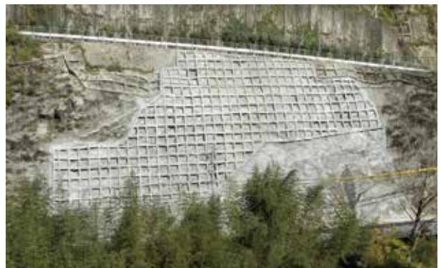
【現場吹付法砕工】
