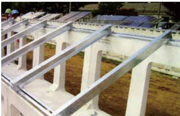
⑤モジュール受材取付け
