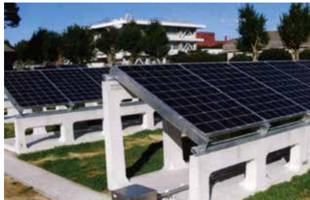
⑥モジュール取付け
