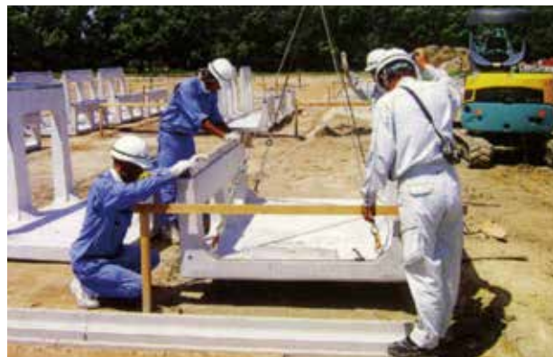
②製品敷設
