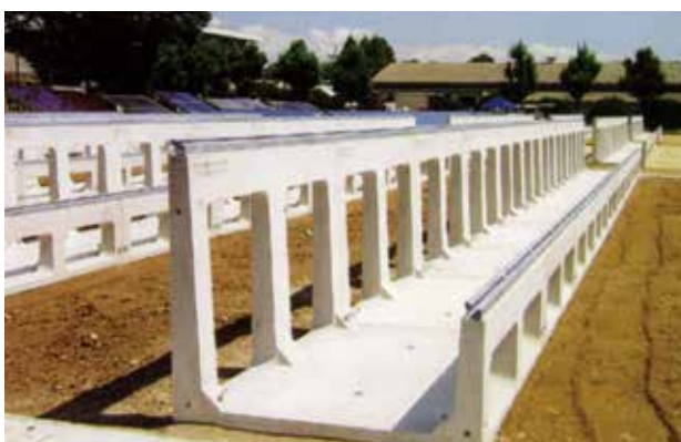
③レールアンカー取付け
