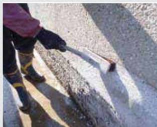
プライマー塗布 (使用量0.15kg/m 2 )
