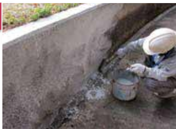
プライマー工 | プライマー塗布
