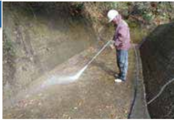
下地処理工-1 | 高圧洗浄
