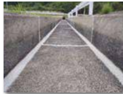
現場打ち水路(ハンチ設置)
