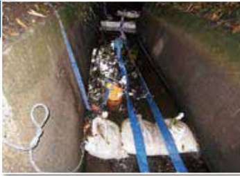
仮設 - 1 | 仮締切・ポンプ設置
