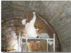
水路トンネル
