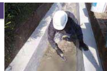
仕上塗工 | 底板部塗工
