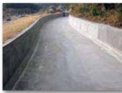
三重県 基幹水利施設 ストックマネジメント事業
