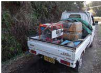
下地処理工-2 | 高圧洗浄機
