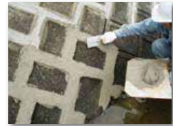
間知ブロック(目地詰め)
