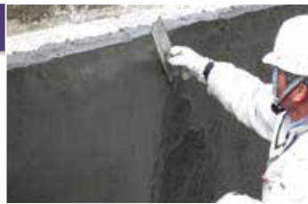
仕上塗工 | 壁部塗工
