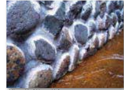
雑石積(施工後)
