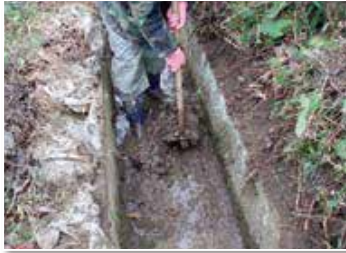
仮設 - 2 | 堆積土砂撤去
