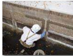
プレハブ水路(棚工)
