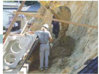
3 裏込材料の投入
