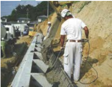
4 胴込コンクリートの打設
