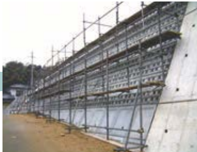
5 据付け完了及び足場設置
