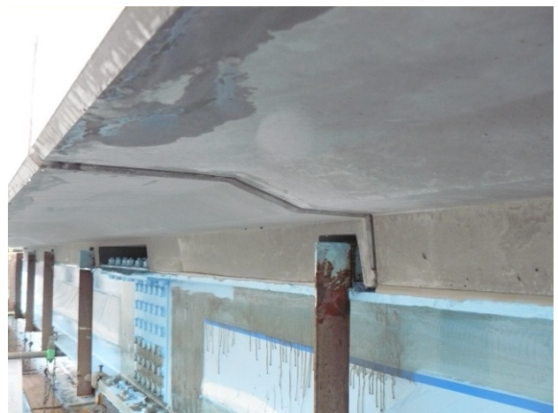
脱型直後のダクトスラブ（幅 2600mm×厚 320mm×長 3120mm。歩道幅 2000mm、最少厚 60mm） 6 ピース納入しました。
