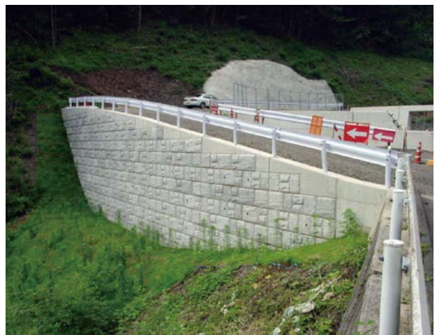
日向土木事務所 立岩谷川通常砂防事業
