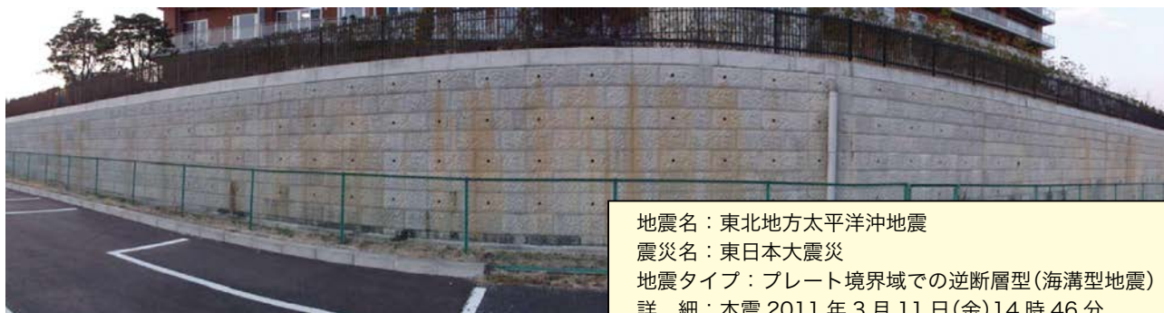
2011年3月29日撮影 宮城県仙台市泉区(物件箇所震度6弱) 大谷石模様 H=3~8m ブロック段数11~13段
