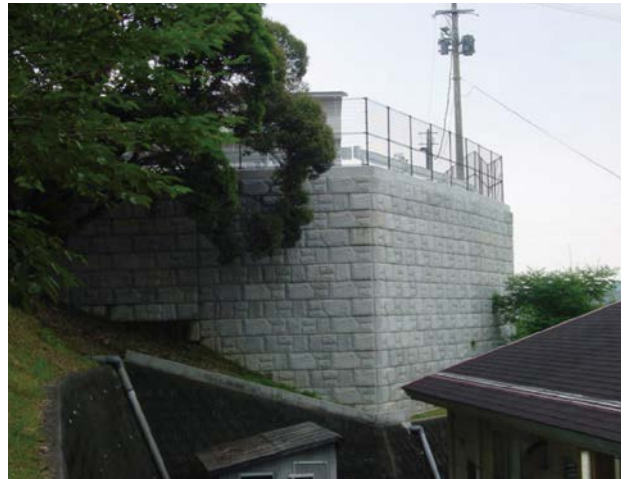
宮崎県営繕課 日向警察寮造成工事
