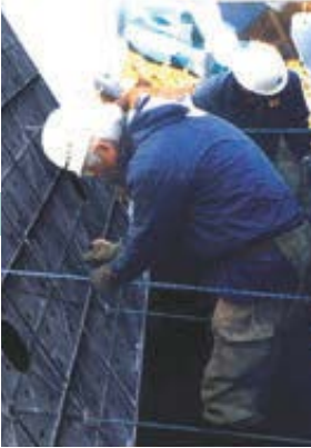
5 KCパネルの固定
