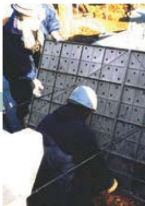
2| KCパネルの取付け
