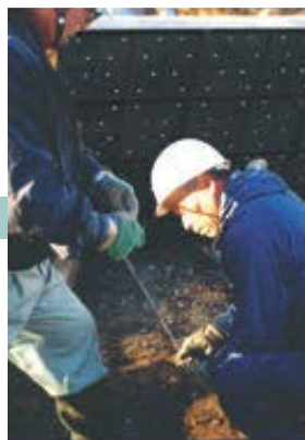
3| KCパネル固定ナットの取付け
