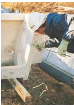
1| セパレーターの取付け
