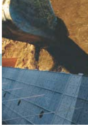
6 裏込材料の投入
