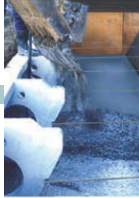
7 胴込・裏込コンクリートの打設
