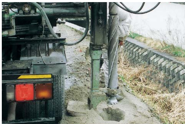
①削孔、深さ検査(φ150-1700mm程度)
