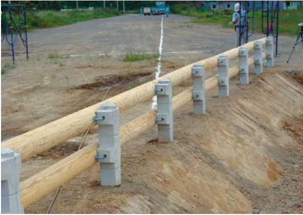
ウッドGr-P型設置状況(背面)
