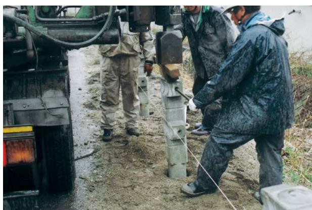
③鉄筋コンクリート支柱高さ調整・孔詰め
