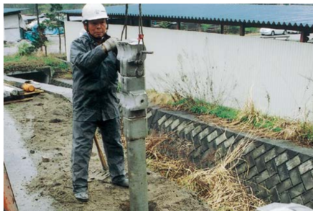
②鉄筋コンクリート支柱挿入
