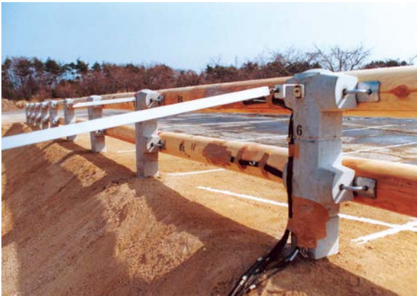
ウッドGr-P型設置状況(背面)
