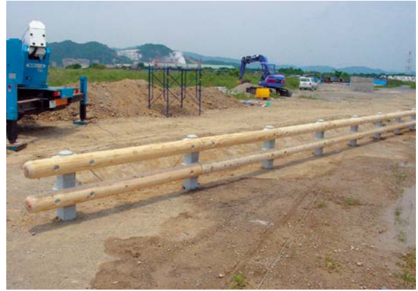
ウッドGr-P型設置状況(正面)
