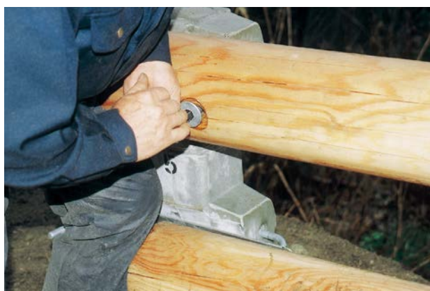
⑤木材取り付け、Rナット締め付け
