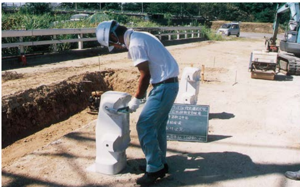
⑪ 連結プレート取付
