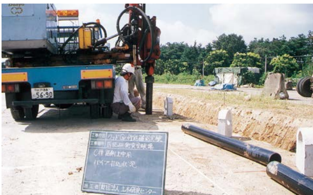
③鋼管打込み
