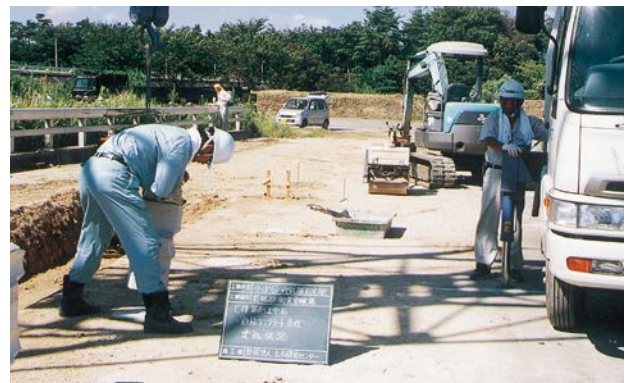
⑧支柱建て込み
