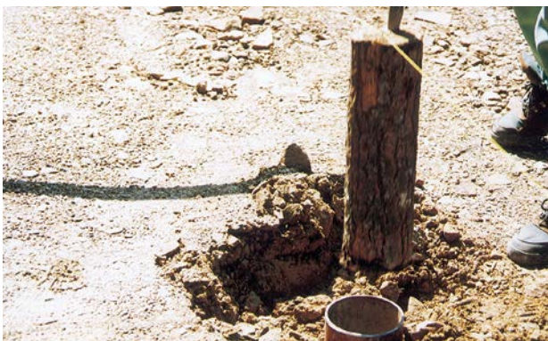
④パイプに丸太を入れて打込む事で 土出しが少なくて済みます
