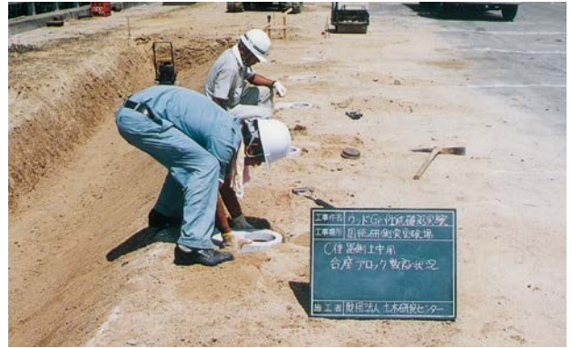
⑤台座ブロック据付
