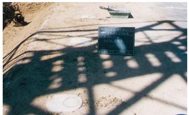
⑦モルタル充填完了
