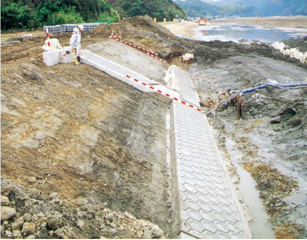
法面成型完了
