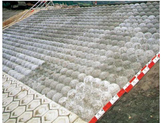
製品敷設完了
