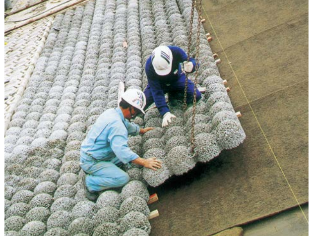
製品敷設状況 (連結金具を利用)
