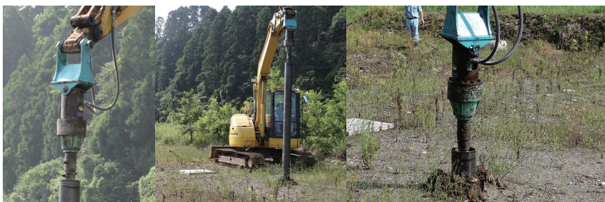
バックホウに油圧オーガーを取り付け、専用鋼管(先端ネジ、取付アタッチ付き)で先行穴掘削。
