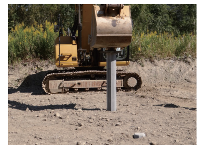
通常バックホウで建込みと挿入
