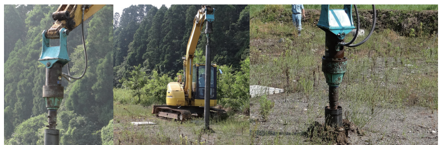
油圧オーガー付きバックホウに取付けた専用ピンで先行穴を無排土掘削し建て込む
