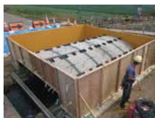
バックフィル用型枠組立完了
