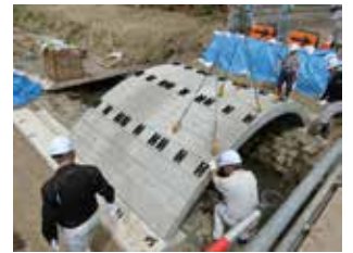
アーチリング据付
