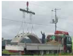
アーチリング吊上
