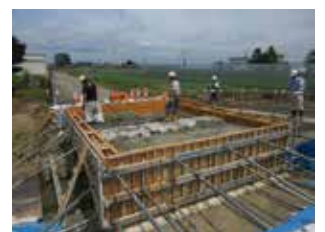
バックフィルコンクリート打込
