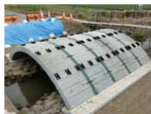
アーチリング施工完了
