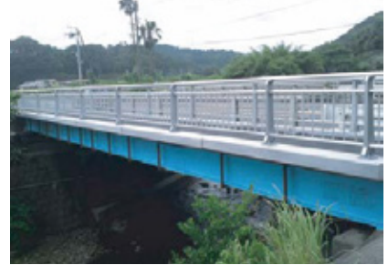
幅2600mm×厚さ320mm×長さ3120mm (歩道幅 2000mm、最少厚 60mm)
