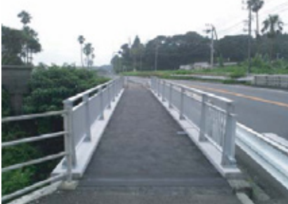
転落防止柵用のアンカーボルトを埋め込んで製造。ダクトアルスラブ上にアスファルト舗装実施
