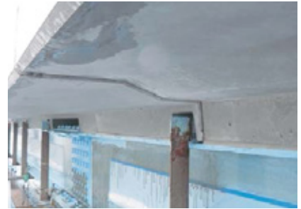
桁の添接板やパイプ等の保持金具等に干渉しないよう、ダクトアルスラブに切欠き実施
