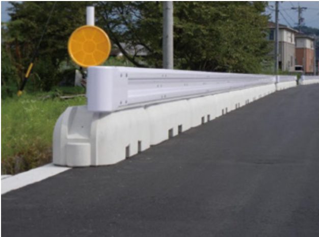
置き設置にて施工
