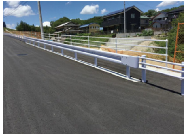
埋設設置にて施工
