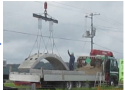
3 アーチリング吊上げ
