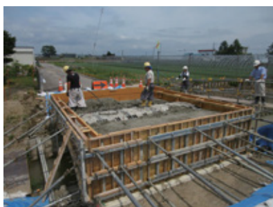
8 バックフィルコンクリート打込み
