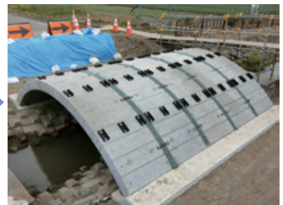
6 アーチリング施工完了
