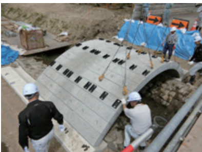
4 アーチリング据付け
