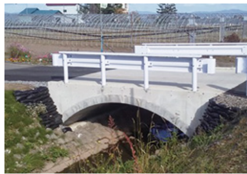
NEPアーチによる改修後
