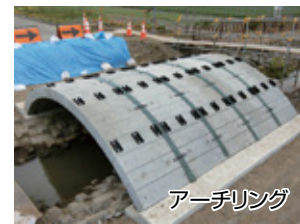
アーチリング：支保工と底面型枠の役目
