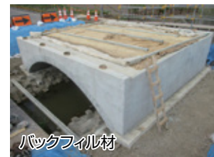
アーチリング：支保工と底面型枠の役目
