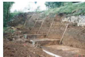
①掘削状況
