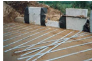
④ストリップの敷設状況
